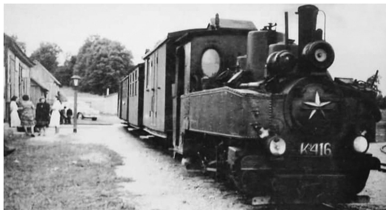
Siauruko sąstatas Taručių geležinkelio stotyje
