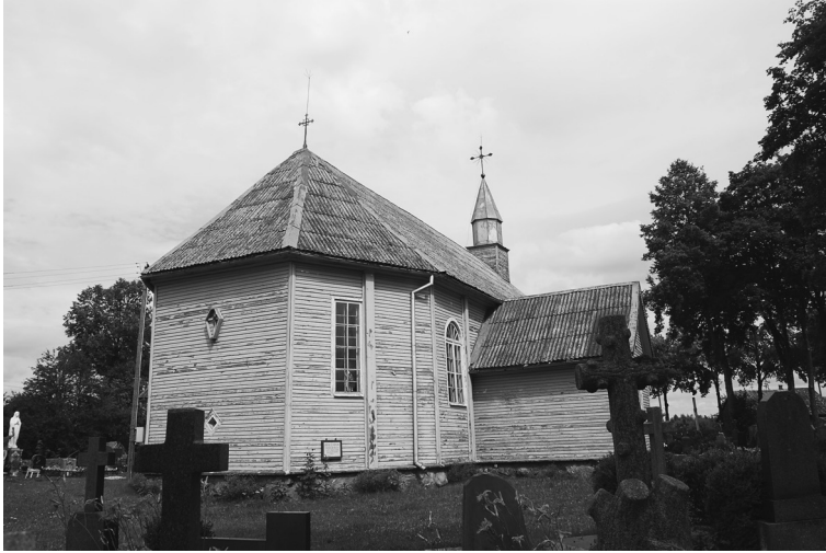
Lauko Sodos bažnyčios apsidės fasadas. 2011 m. A. Rupeikos nuotr.
